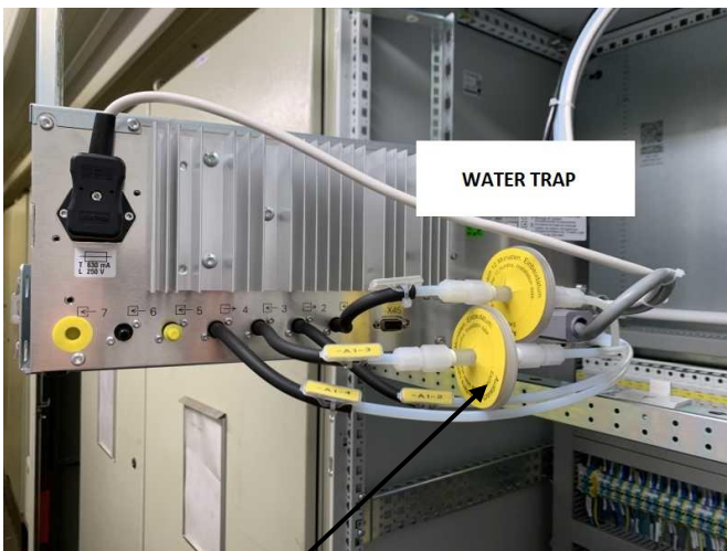
2 x Wasserfalle Modell 205N vor Analysator geschaltet (2 Messkanäle)
